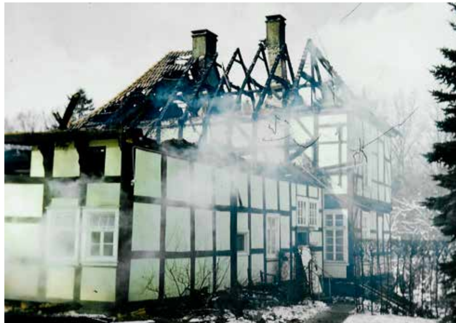
Ein Brand zerstörte 1970 das damals zweitälteste Gebäude im Ort.
